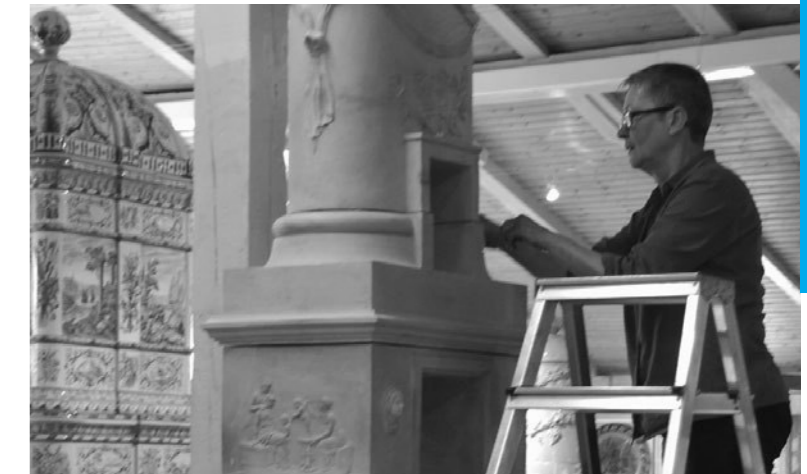
Maike Arndt beim Verfügen des Aufsatzofens 'en biscuit' in Velten, 2011
