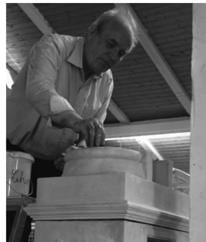
Udo Arndt beim Aufbau eines um 1800 entstandenen Ofens in Velten, 2011
